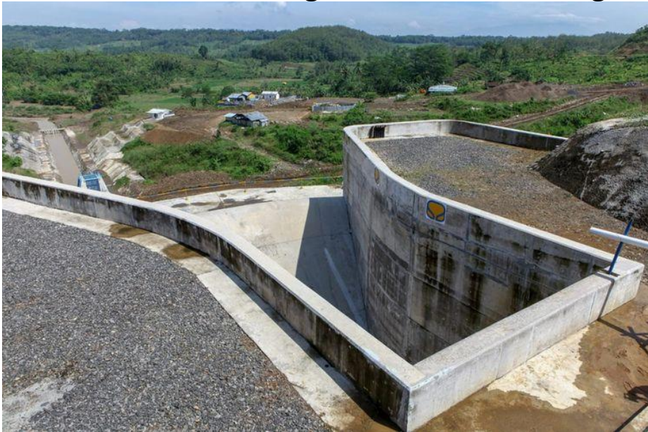
Gambar 4.38 Pembangunan Waduk Cileuweung
